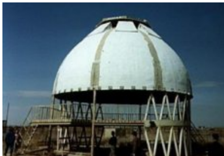
Ciò che resta di un serbatoio del missile N1.
