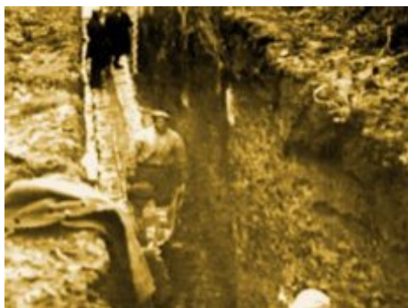
Il fosso, lungo circa 38 metri e profondo 4, venne realizzato dalla spedizione di Kulik per eliminare l'acqua dalla palude centrale con lo scopo di rintracciare il presunto cratere d'impatto.
