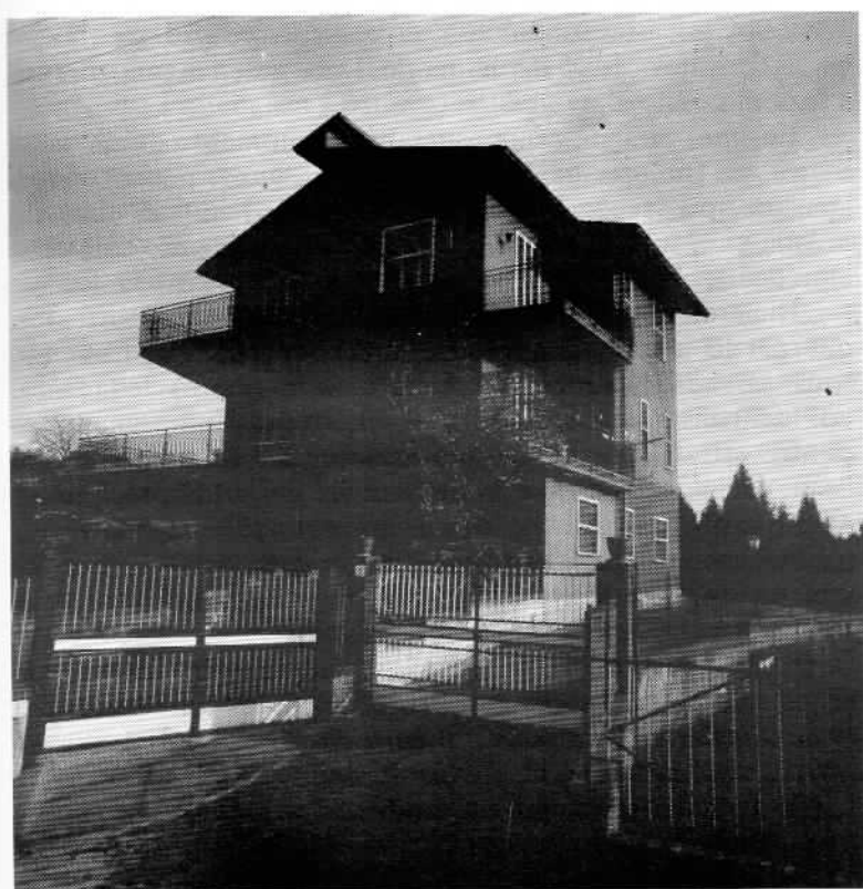
Chalet de la Sra. Cantin, cuyo apartamento de la planta baja ocupaba Siragusa al ser detenido.
