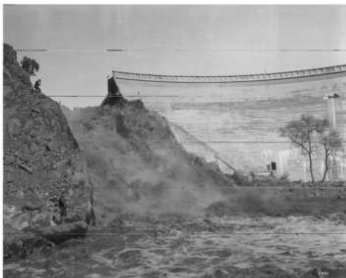
Il cedimento della diga di OTAY a causa delle piogge
